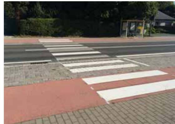
▲ Nieuwe oversteeplaats op de Brusselbaan ter hoogte van de Molenberg.
