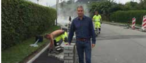
Nieuwe voetpaden en oversteekplaatsen p. 2
